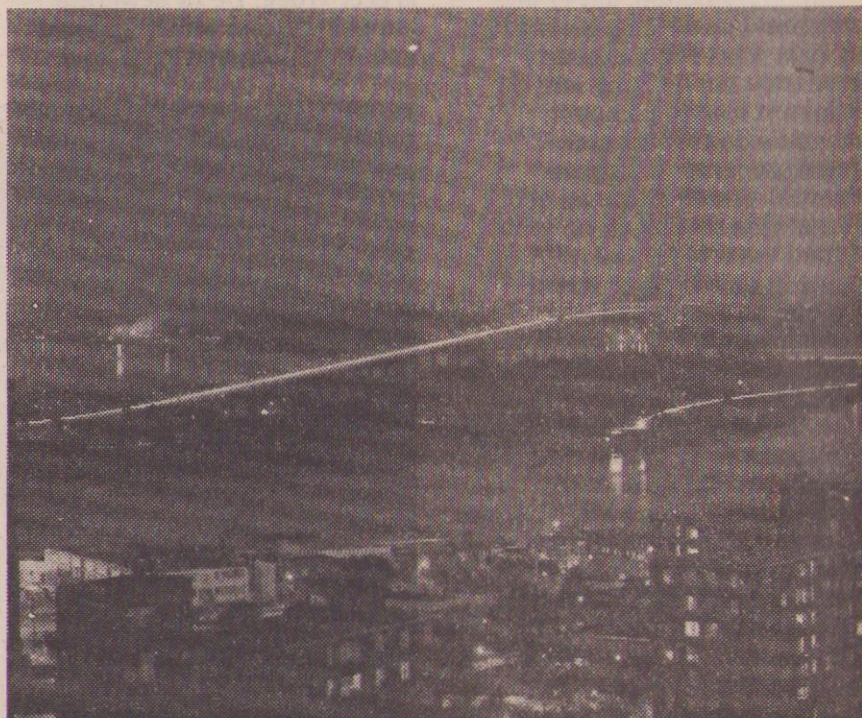
Lage druk natriumlampen SOX 180 W verlichten de 'White Stone'-bridge in New York. Deze lampen krijgen in Amerika steeds meer aandacht i.v.m. hun gunstige verhouding tussen laag energieverbruik en hoge lichtopbrengst.
